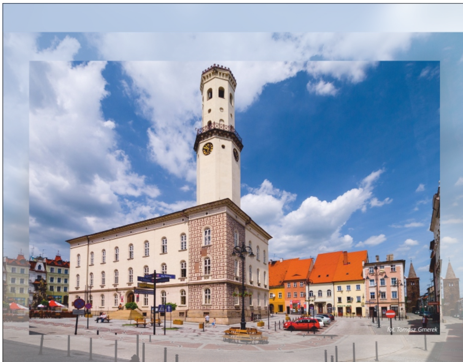
Ratusz w Bystrzycy Kłodzkiej Radnice v městě Bystrzyca Kłodzka City hall in Bystrzyca Kłodzka Rathaus in Bystrzyca Kłodzka (Kabelschwerdt)
